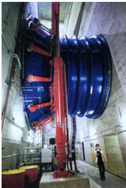
Grâce à cette cinquième turbine, la centrale hydroélectrique dispose d'une puissance installée de 148 MW.
